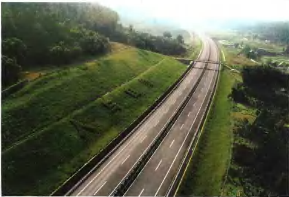
▲ 人与自然——四川成雅高速公路边坡防护（四川成雅高速公路公司提供）
