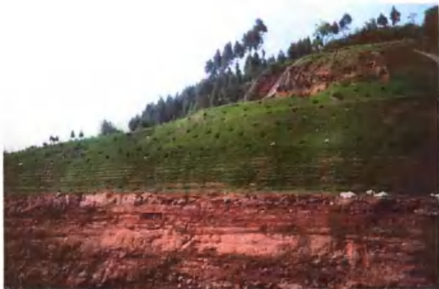
▲ 上边坡挂三维植被网喷播 1个月后的现场
