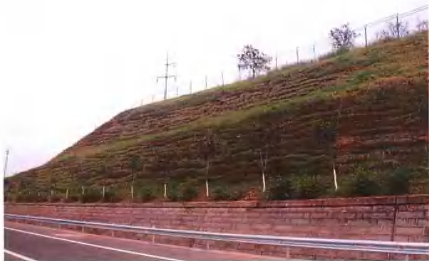
▲ 上边坡开沟植草绿化（四川高速公路绿化环保开发公司提供）
