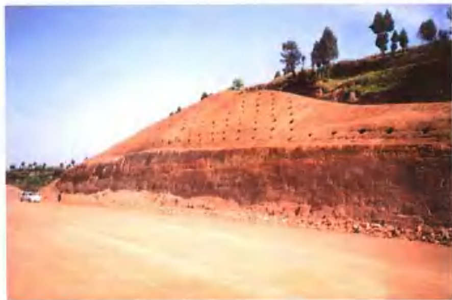
▲ 上边坡挂三维植被网覆土后现场
