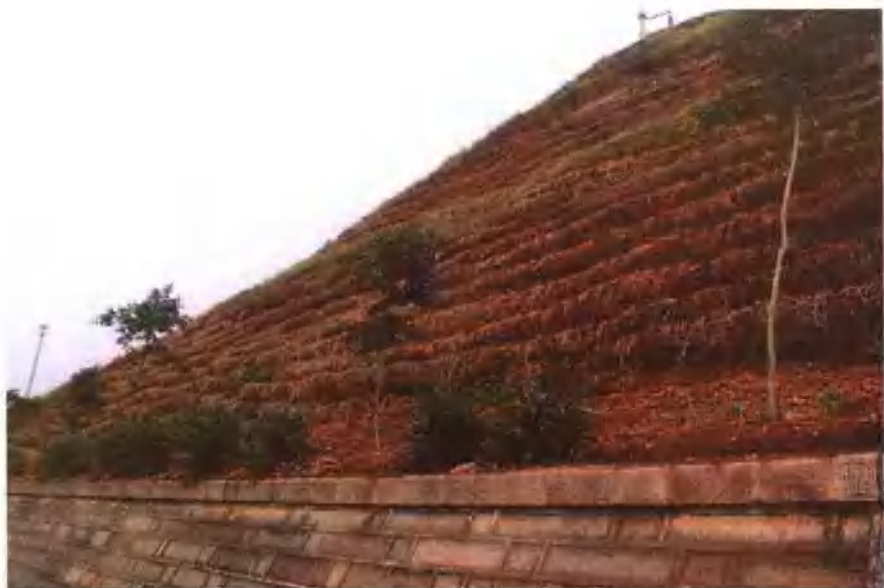
▲ 上边坡开沟种植野生狗牙根草护坡（四川高速公路绿化环保开发公司提供）
