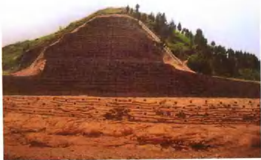
▲ 上边坡挂三维植被网现场（四川省林丰园林建设工程公司提供）
