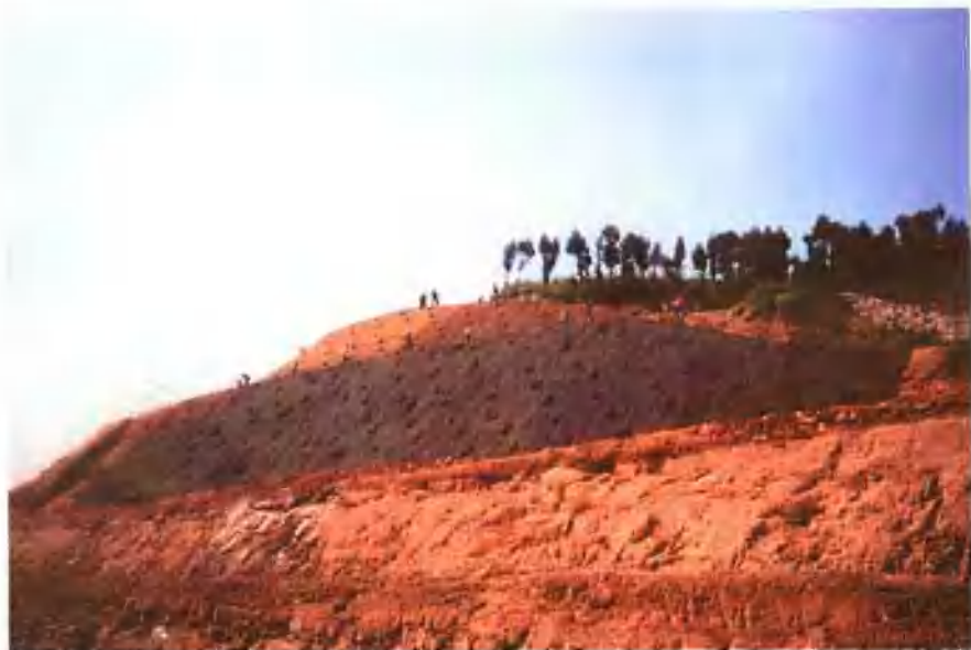
▲ 上边坡挂三维植被网覆土现场
