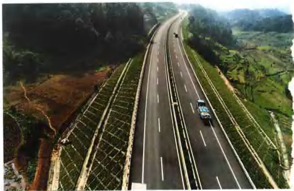
▲ 下边坡网格植草工程模式（四川高速公路绿化环保开发公司提供）
