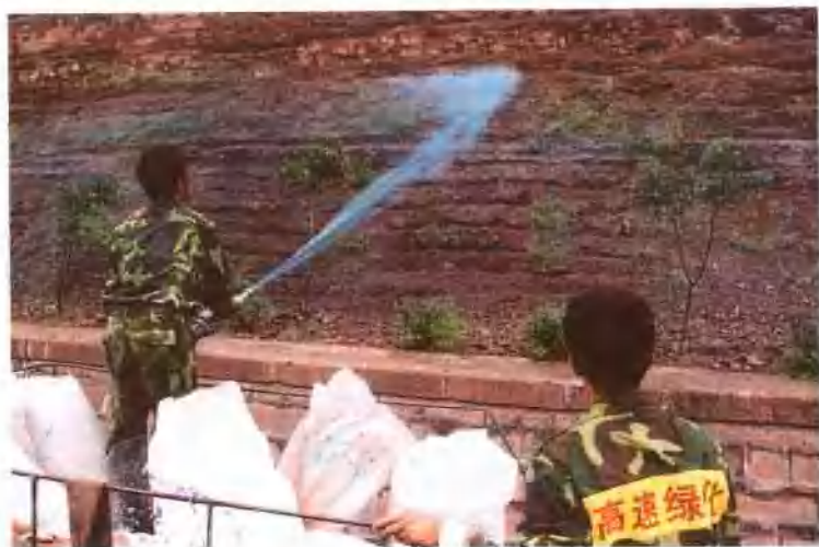
▲ 液压喷播现场（四川省林丰园林建设工程公司提供）
