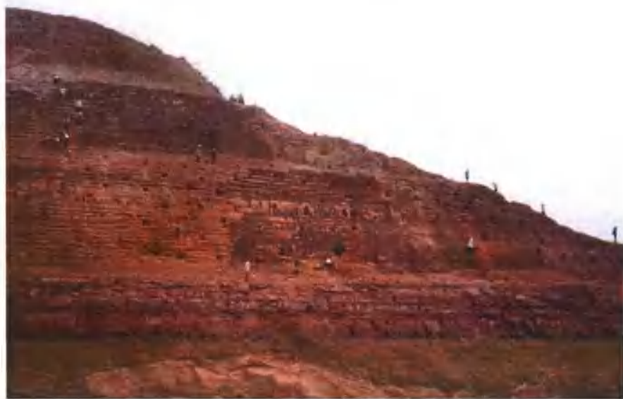
▲ 上边坡开沟覆土工程（四川省林丰园林建设工程公司提供）
