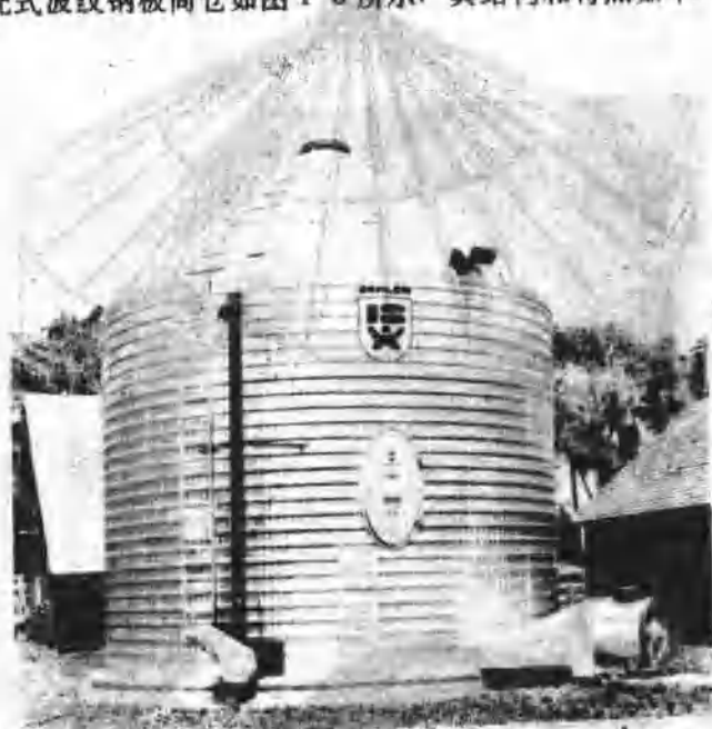
图 1-8 带干燥系统的波纹钢板筒仓
