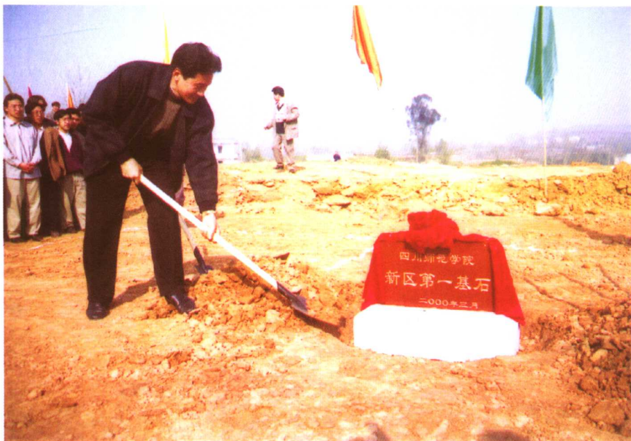
党委书记、院长余正松为新区建设开工奠基（2000）
