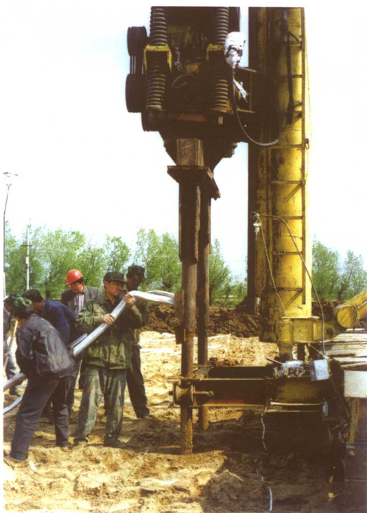
袋装砂井施工
