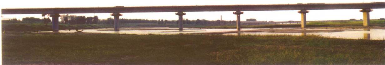
大凌河特大桥
