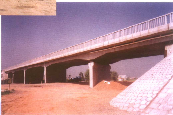
跨 102 国道 3 号 刚构连续梁大桥
