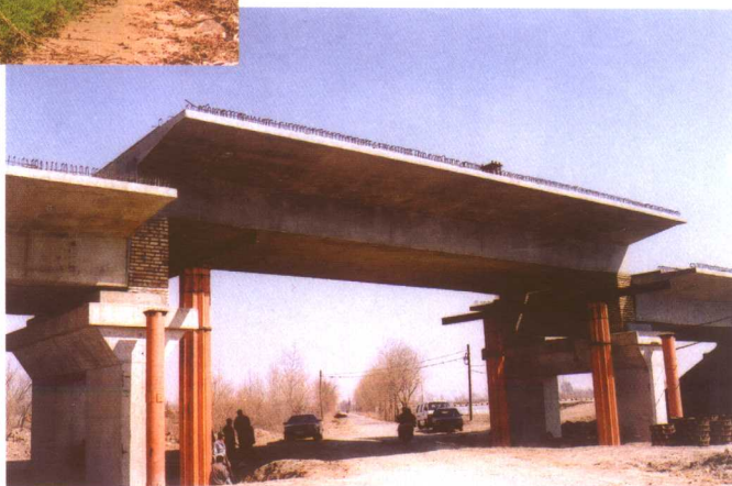
(卡力马 1 号中桥) 24 m 双线整孔箱梁
