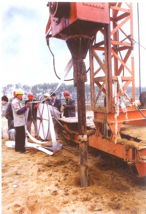
塑料排水板施工
