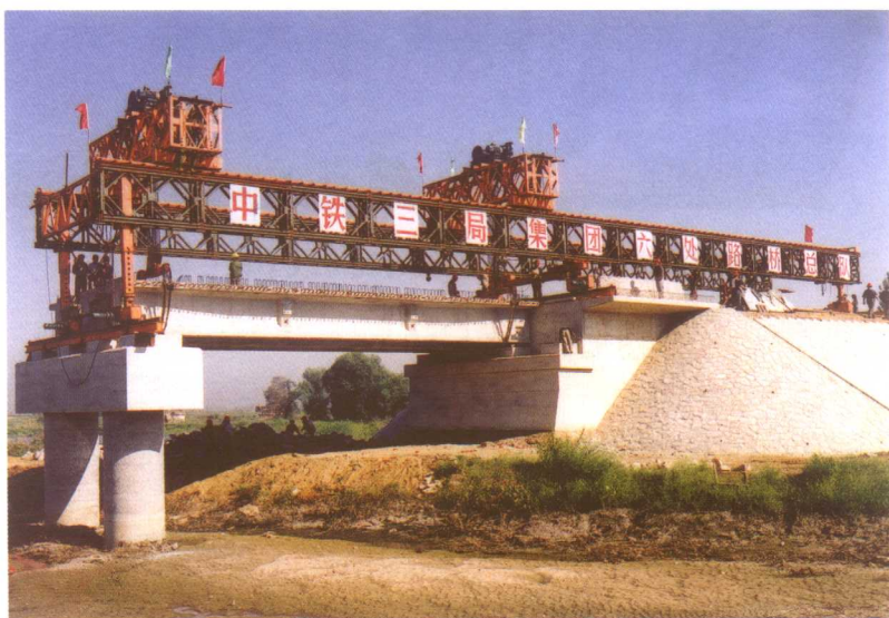
小浑河中桥架设 16 m 分片式 T 形梁
