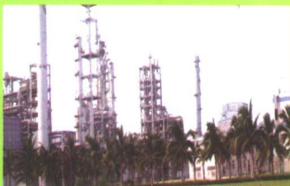
海南富岛化肥厂厂区一角
