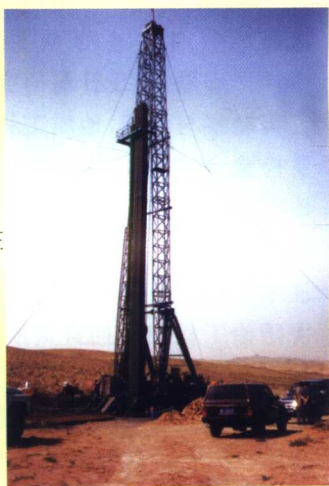
宁夏石油施工现场
