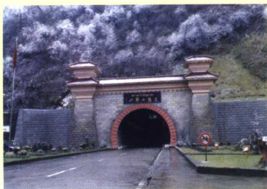
二郎山隧道勘察施工现场
