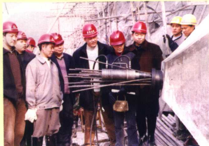
紫坪铺水利枢纽工程预应力锚索施工现场
