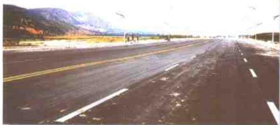
新修崆峒大道
