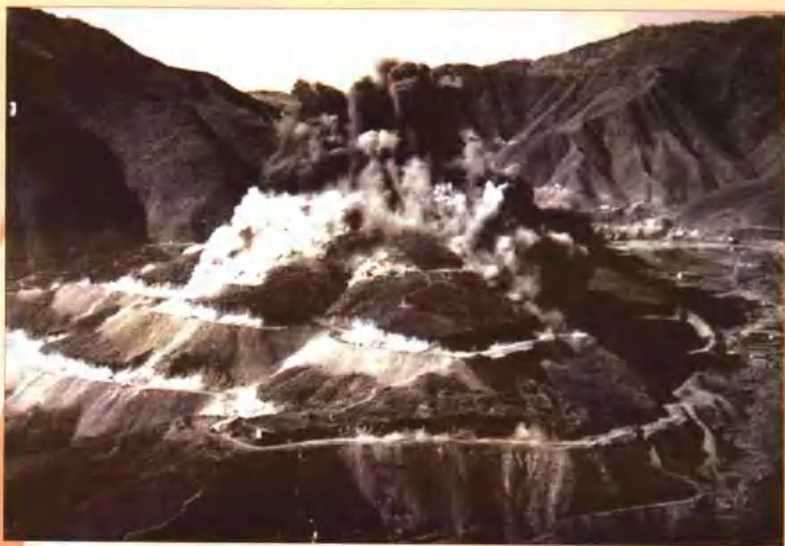
▲1971年5月21日上午10时59分,经周恩来总理亲自批准的朱家包包铁矿狮子山万吨炸药大爆破成功起爆,爆破松动岩石1140万立方米,产生的爆破震动相当于4.2级自然地震
