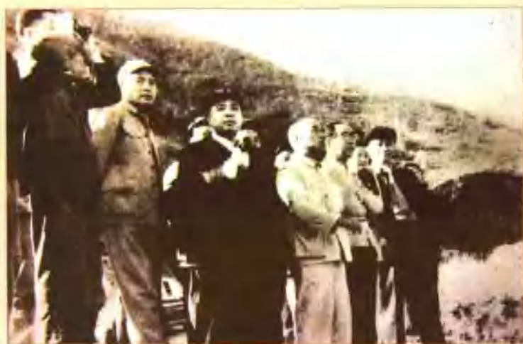
▲1964年10月，李富春（前排右三）、薄一波（前排右二）视察攀枝花建设工地
