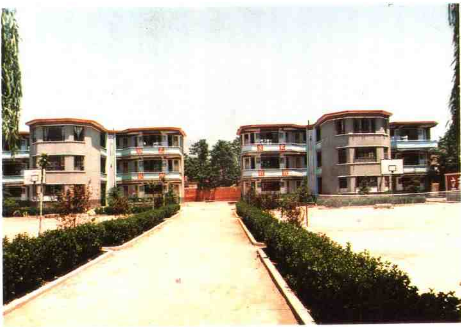
1985年新建的县直初中八角教学楼
