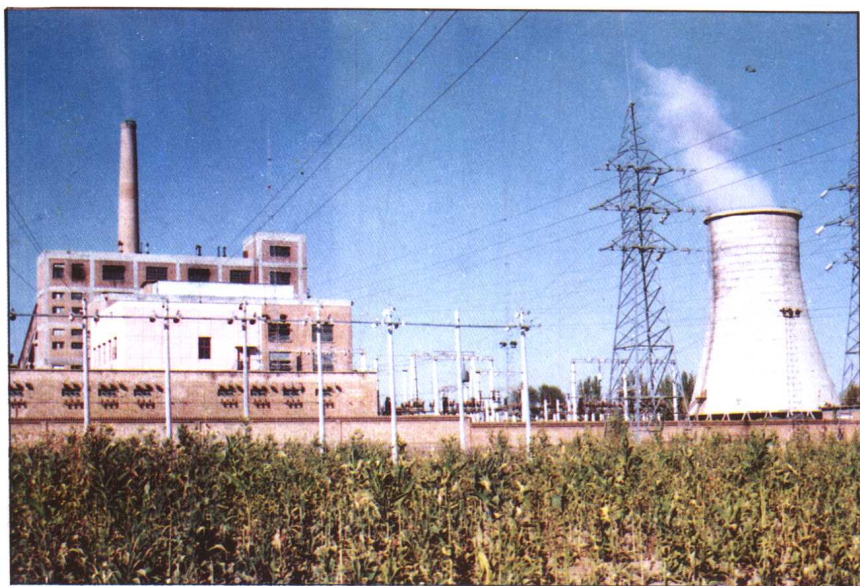
1. 蔚县南留庄发电厂
