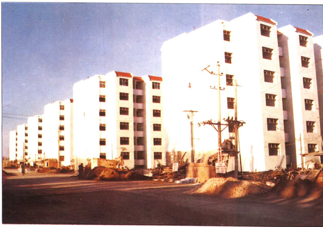
1. 县城居民住宅楼群
