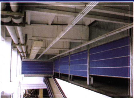
▲无机特级防火卷帘门整体安装图
