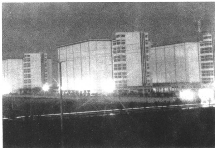
图 1-1 54 000t 吴泾冷库建筑群外观
