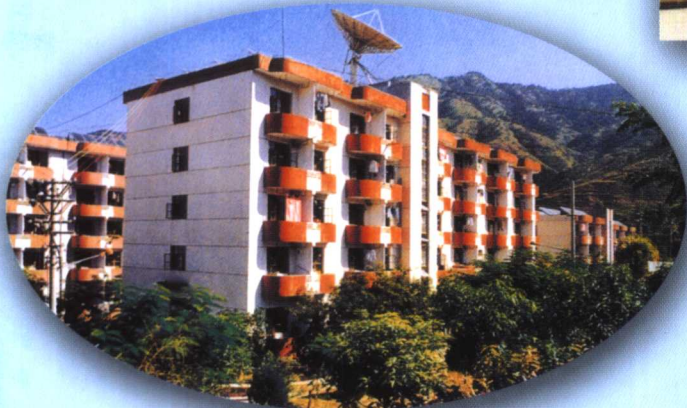
施工区生活营地
