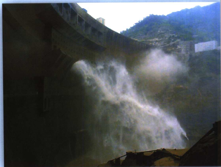
大坝中孔泄洪关闭过程
