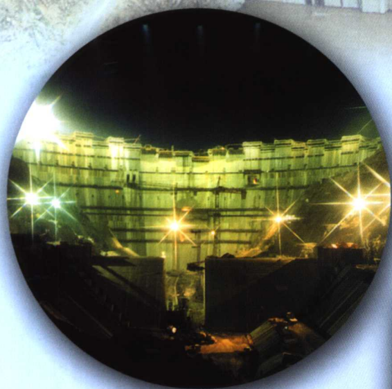
二滩拱坝夜间施工
