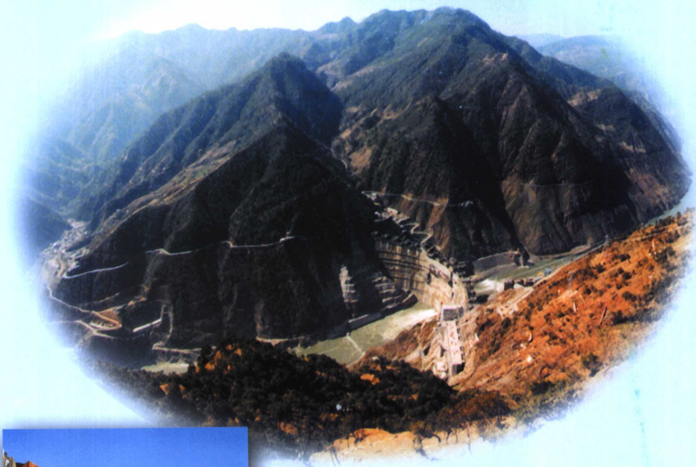
二滩水电站建设工地远眺
