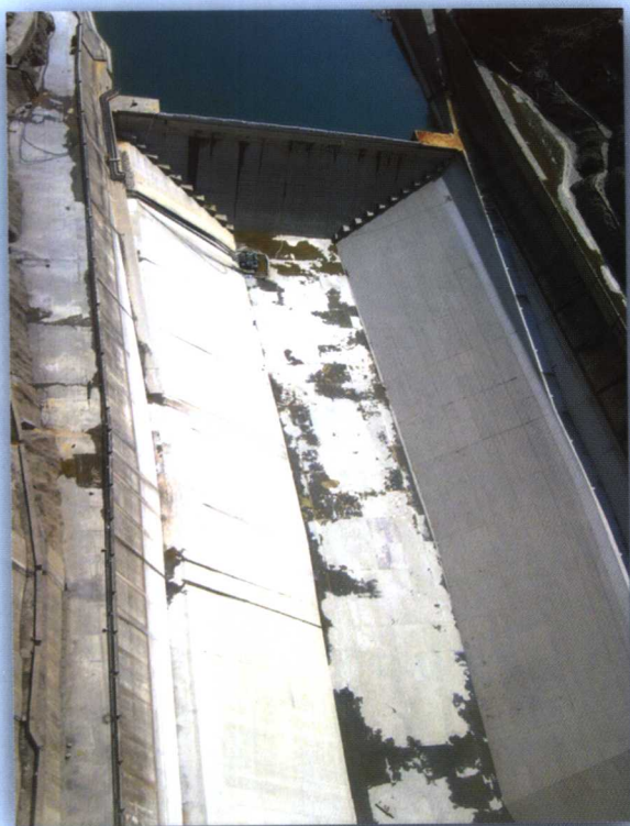
水垫塘和二道坝运行后抽水检查
