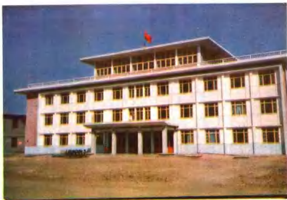
武防县公弗医疗门诊部门诊楼 图片4
