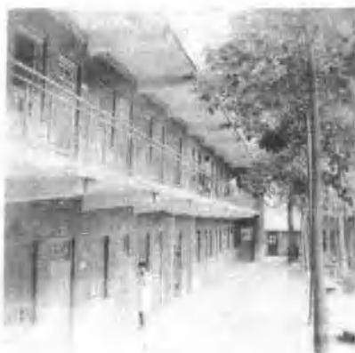
武陟县卫生防疫站检验楼 图片9
