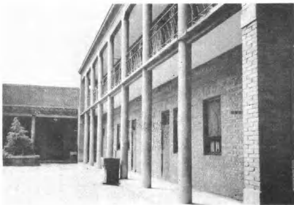
武陟县中医院门诊楼 图片10
