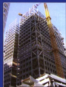
通信时代大厦重钢应用实例
