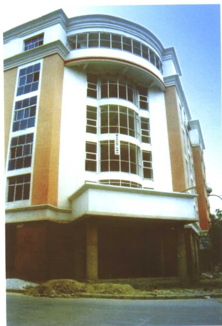
册亨县房地产管理局办公大楼
