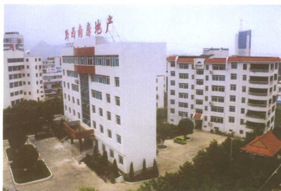
黔西南州房管局办公室及生活区
