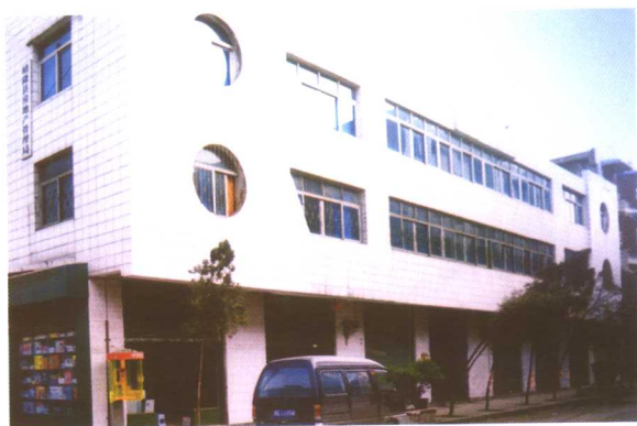
晴隆县房地产管理局办公大楼
