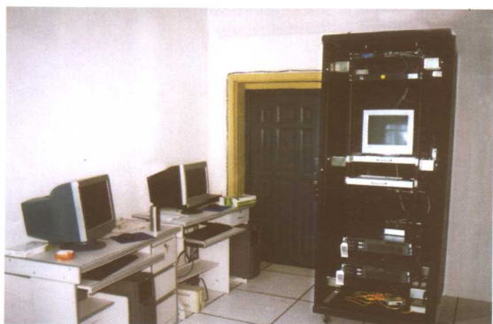
黔西南州房管局住房资金管理系统硬件设施(立式机柜、机架式Hp560服务器两台、天网硬防一台、联想交换机一台、光纤接入)
