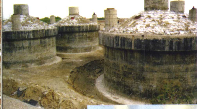
呼和浩特市 超大型污水 消化罐水压控 制爆破拆除工 程 (总注水量 7000 立方米)
