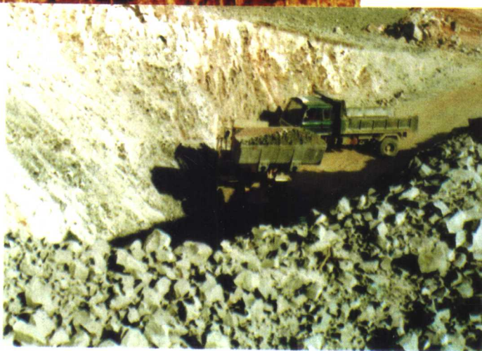
丰—准铁路路堑石方 大爆破工程
