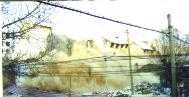
复杂环境中六层住宅 楼多向折叠定向 倾倒控制 爆破拆除工程
