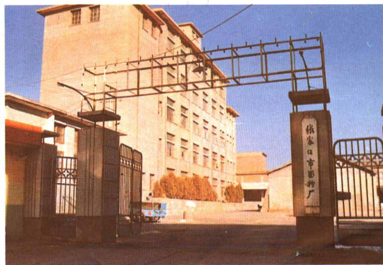
张家口市面粉厂制粉楼外景。
