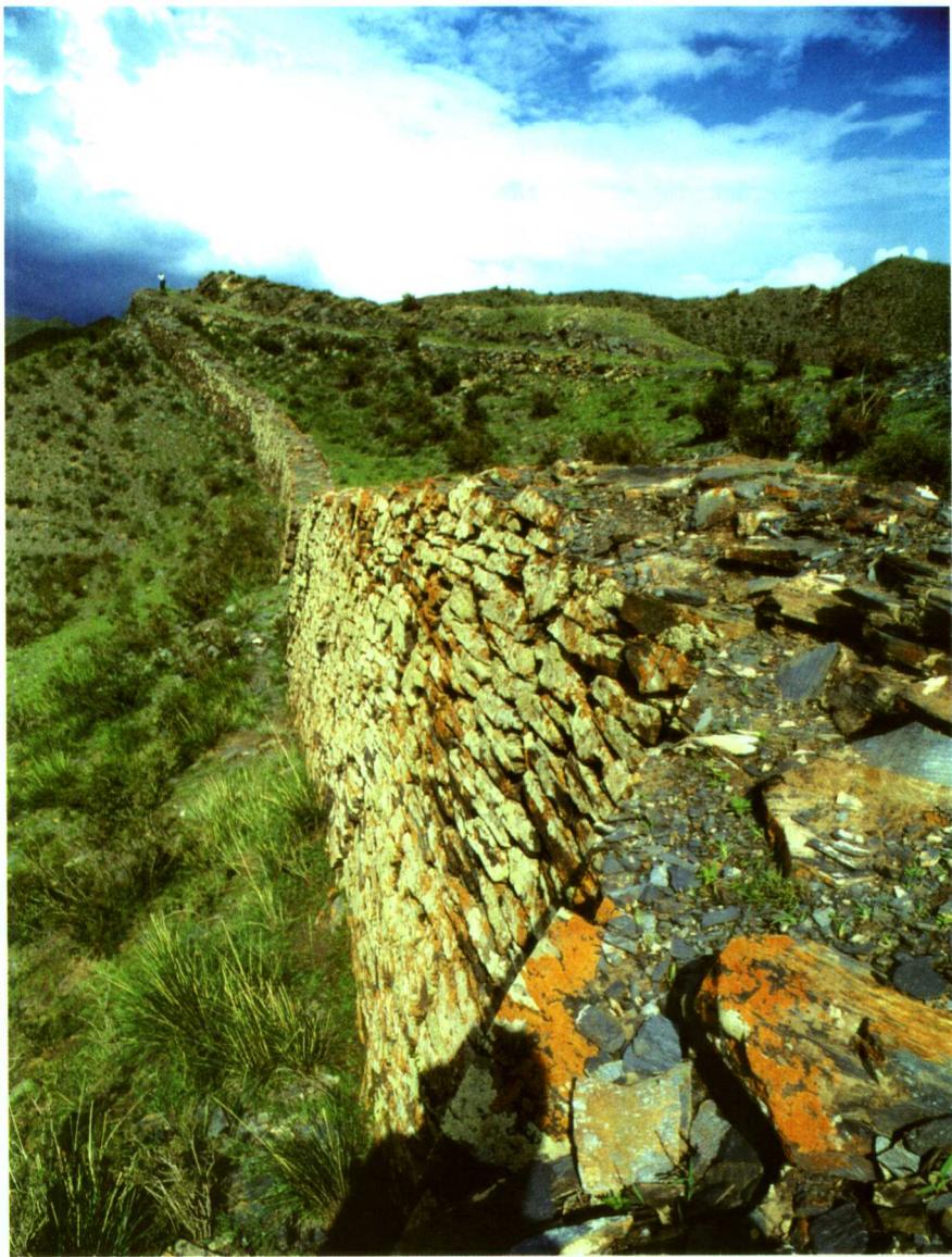
内蒙古固阳境内的秦长城遗址。
