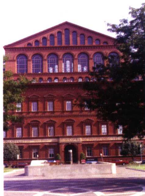
第三届普里茨克建筑奖颁奖典礼的 华盛顿建筑博物馆 (Courtesy of the Hyatt Foundation)
