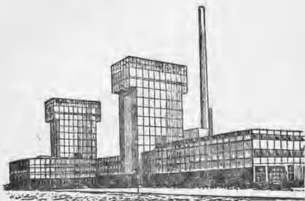
圖 8 罗达林基雅某矿井的塔式井架
