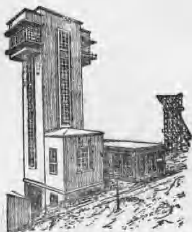
圖 7 罗岩金某一矿井的塔式井架
