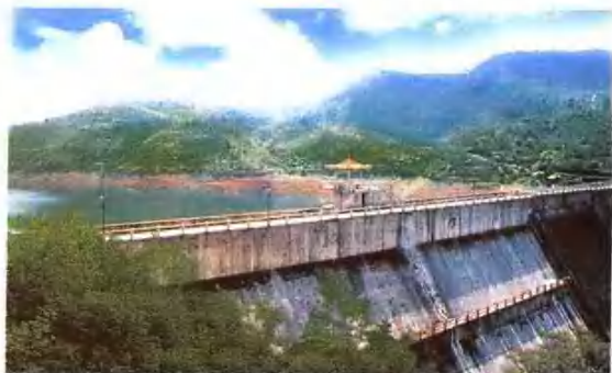
赤坳水库 (浆砌石重力坝) ▶
