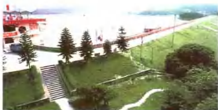
◀ 1986年加固扩建后的铁岗水库
