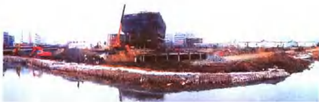
▲ 1995~1996年兴建的罗雨泵站及布吉河河口工程。上图为施工中的布吉河河口，下图为竣工后的布吉河河口。
