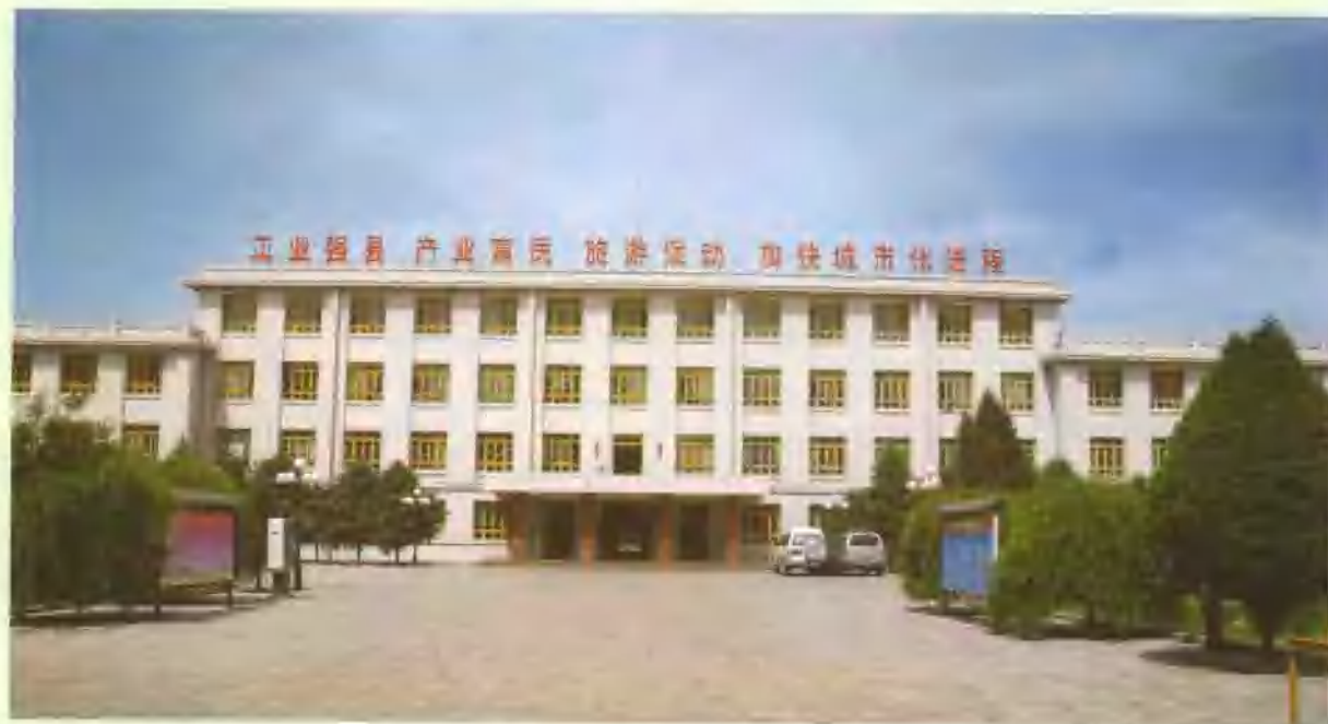
县政府办公大楼
