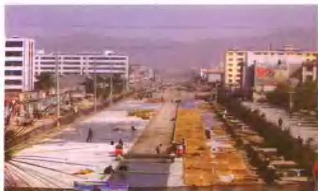
北大路拓建工程
