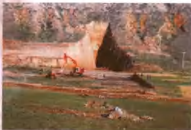
霍城灌区北台子水库施工现场
