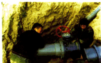
维修施工现场
