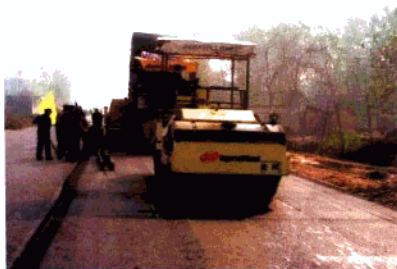
先进的筑路设备为修筑精品路提供了保障。
