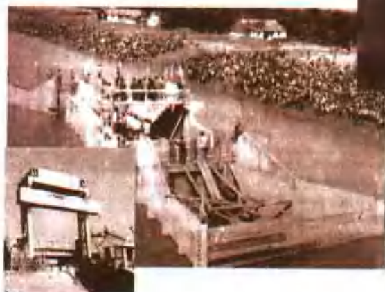
余闸(千吨水闸静水浮运搬家)
