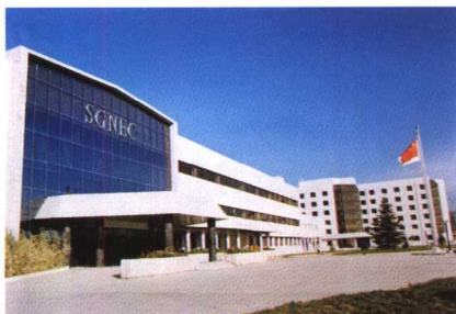
图 11 北京首钢日电公司厂房
