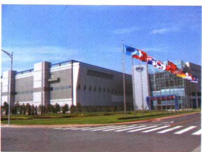
图 15 北京中芯国际公司厂房
