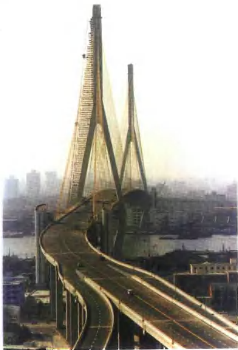
上海杨浦大桥
