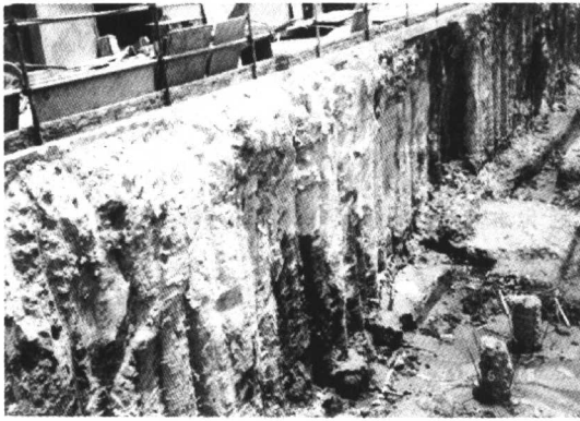
图 1-3-1 水泥土搅拌桩基坑
