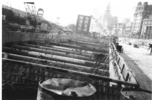
图 1-3-3 地下连续墙施工现场
