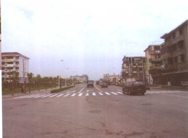
唐陆公路（拓宽后）
