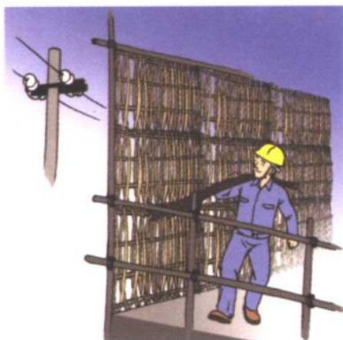
2. 作业人员在高压线防护设施旁搬运钢筋时，应注意不得穿出防护设施，以免碰触高压线路造成事故。
