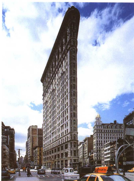
弗拉蒂恩大厦,纽约,建于1899年,该建筑物在每层钢框架外挑厚重的石材饰面。
