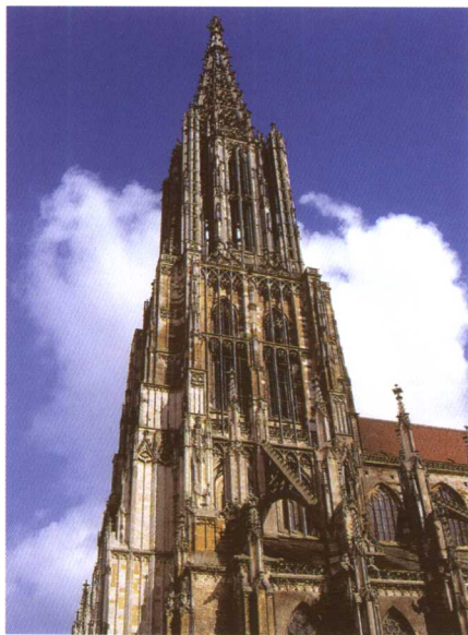
乌尔姆大教堂尖顶,建于14世纪晚期,是迄今为止最高的砌体结构。建筑上部的嵌饰石工减轻了风荷载的作用。
