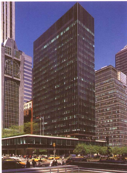
利华大厦，纽约，建于1950年，某公司总部。竖向的大型砌块与铝制玻璃窗墙按比例结合，形成间落有致的漂亮外形。
