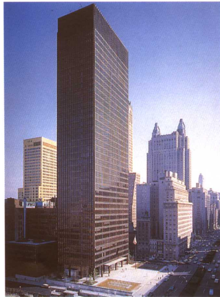
希格玛大厦，纽约，建于1954年，该大厦耸立在一个公共广场的前面，外部采用暴露的钢框架饰面，内部则采用防火钢框架结构。
