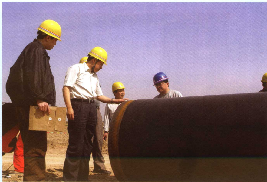
2003 年 6 月所领导带队赴西气东输工程施工现场进行技术服务
