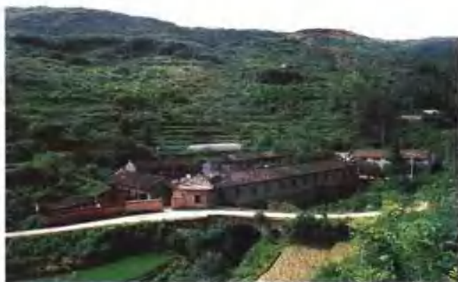
大村水轮泵电站
