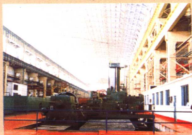
哈尔滨电机厂400t吊车厂房 全国第一座全钢结构重型厂房
