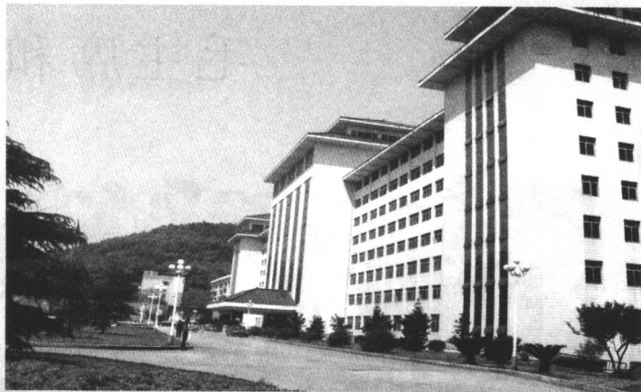
省委党校，湖南行政学院综合大楼。
