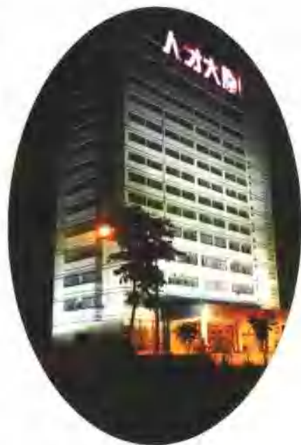
承建的济源市人才大厦
