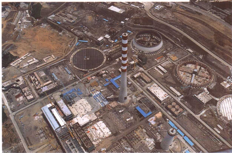
在建的装机容量360万千瓦的盘南电厂 (王述慷 摄)
