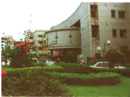
图①为浙江省人民医院病房楼外景及大厅。图②为浙江省儿童保健医院住院楼外景。
