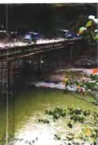
修复新平三江口桥
