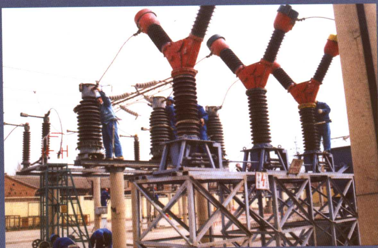
变电站设备清扫
