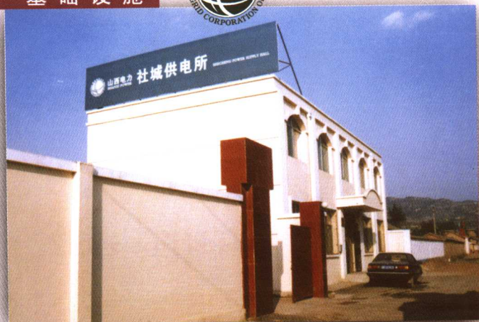
社城供电所办公楼
