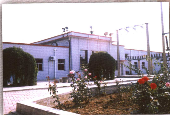
榆社110千伏变电站
