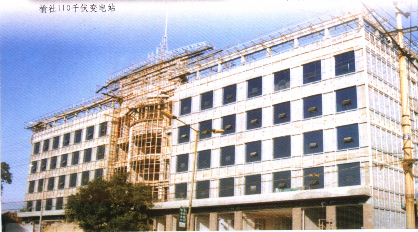
2005年建设中的生产综合调度楼
