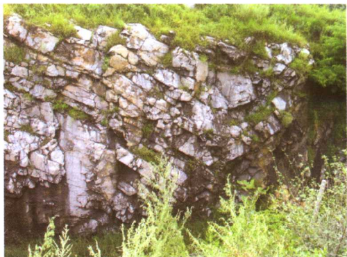
6. 驻操营电力水泥厂门前铁路隧道口向斜
