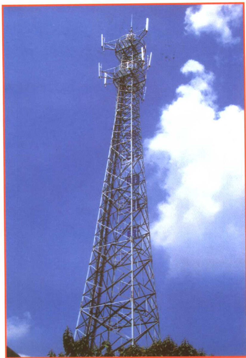
高耸入云的通讯铁塔
