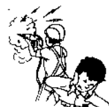
用冲击钻在墙上打孔
