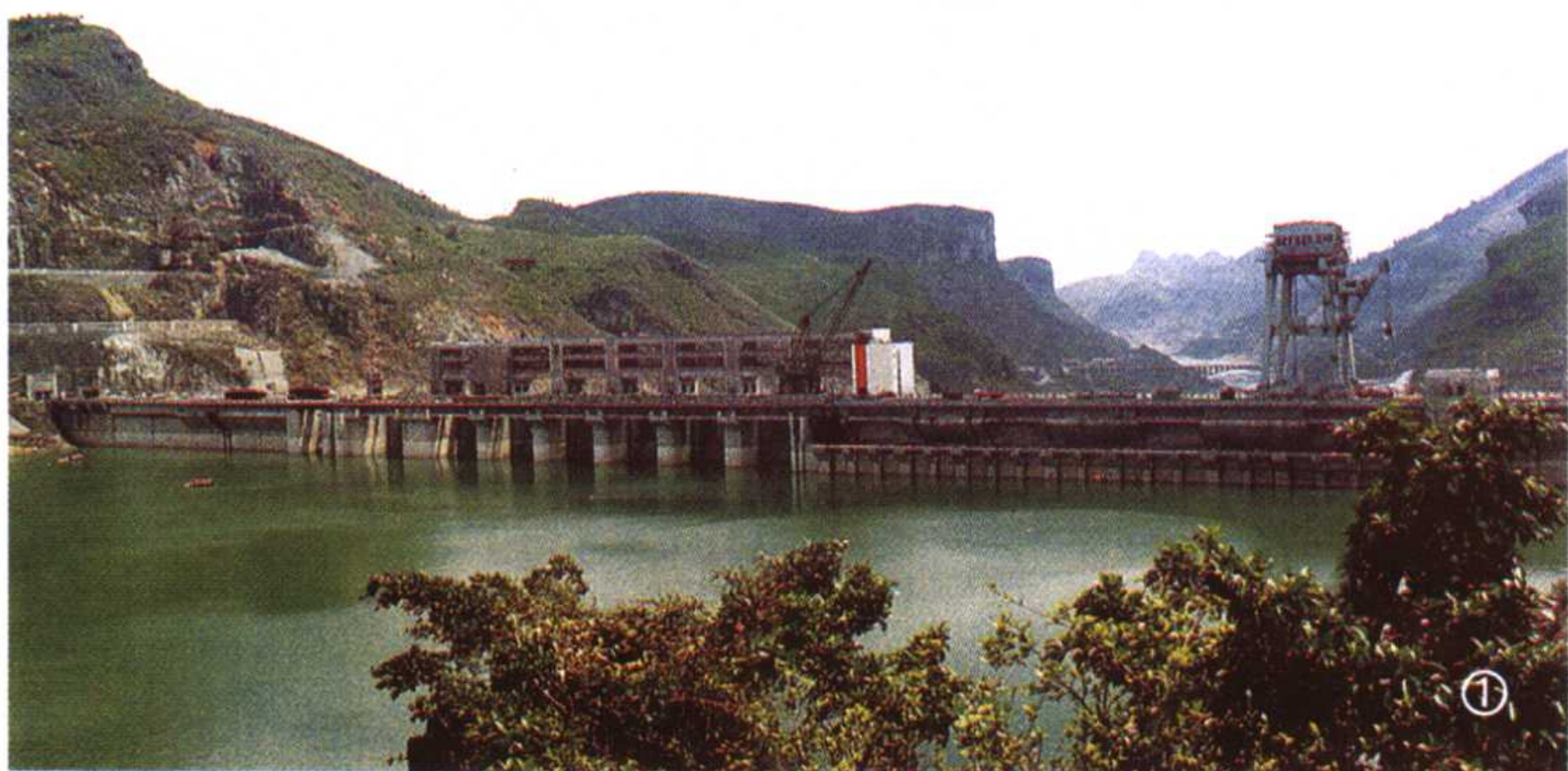
岩滩水电站大坝
