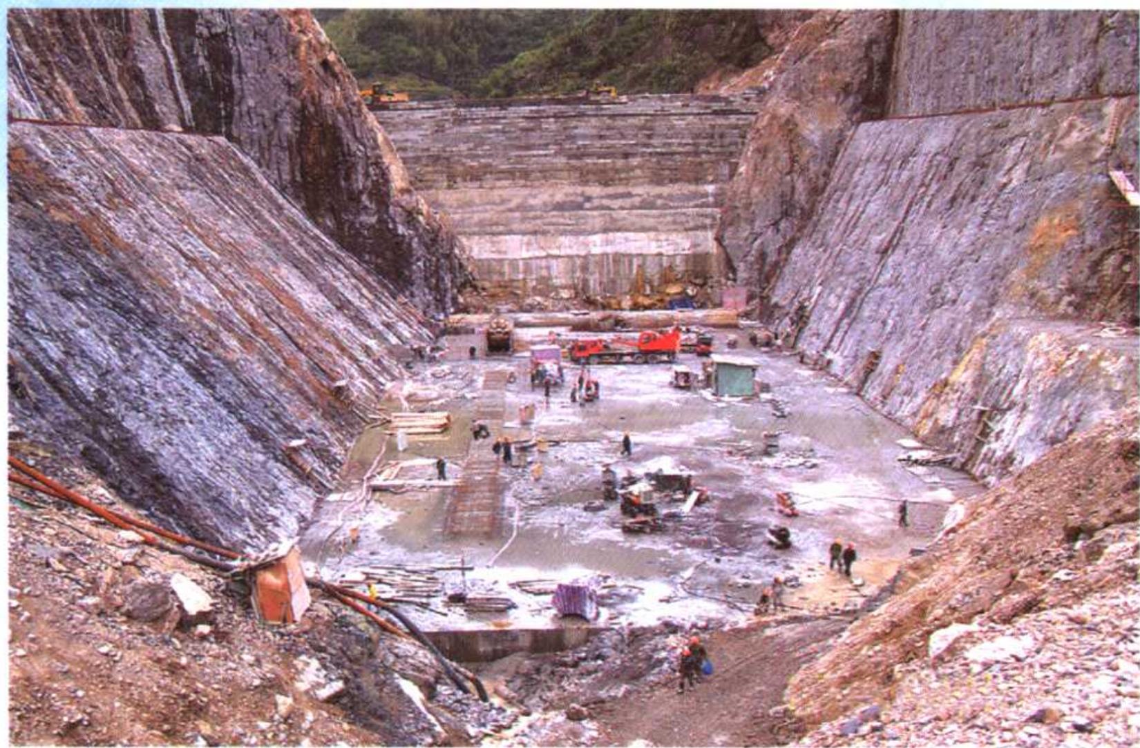
洪口水电站大坝基坑
