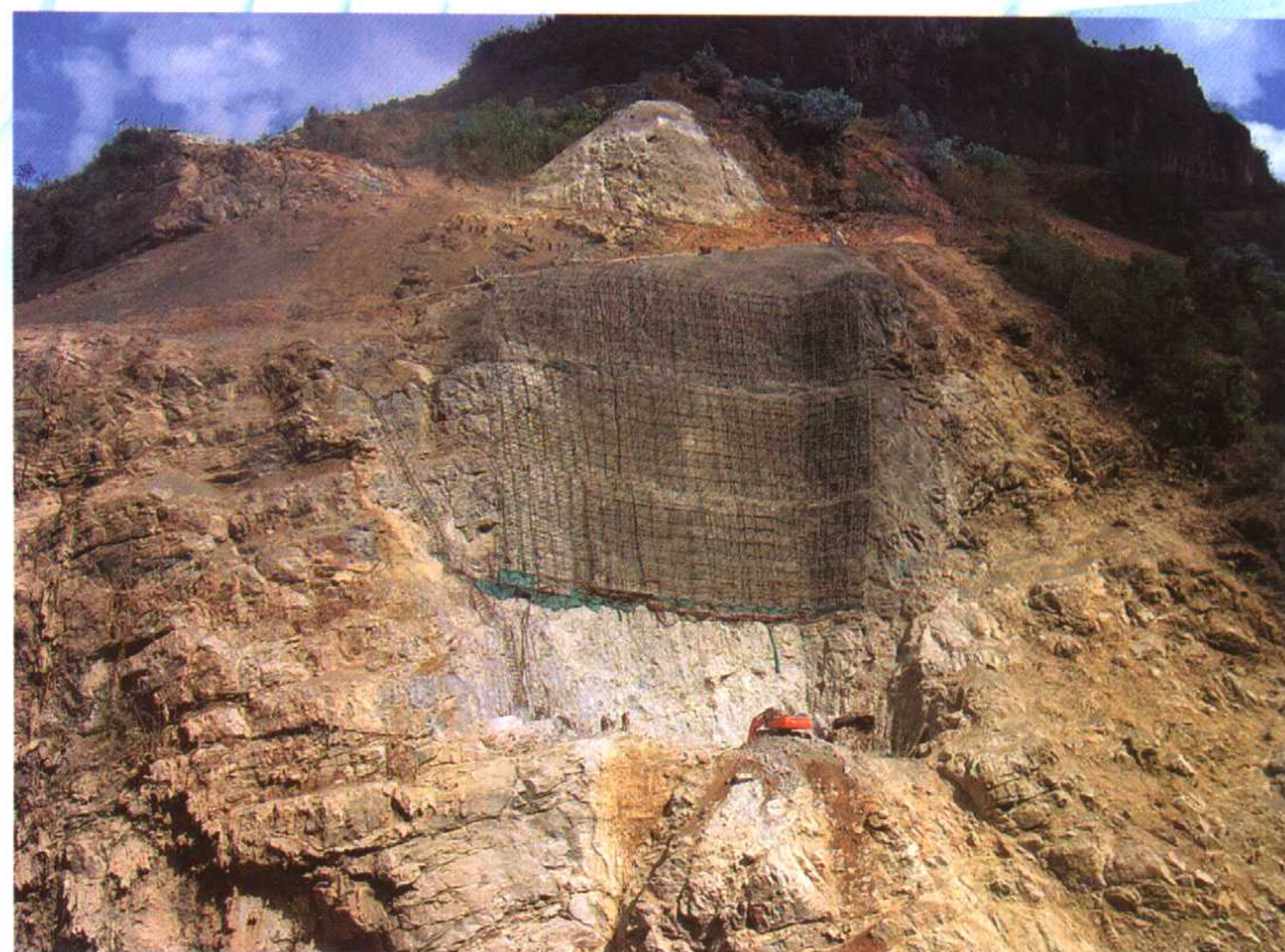
洗马河水电站左坝肩开挖
