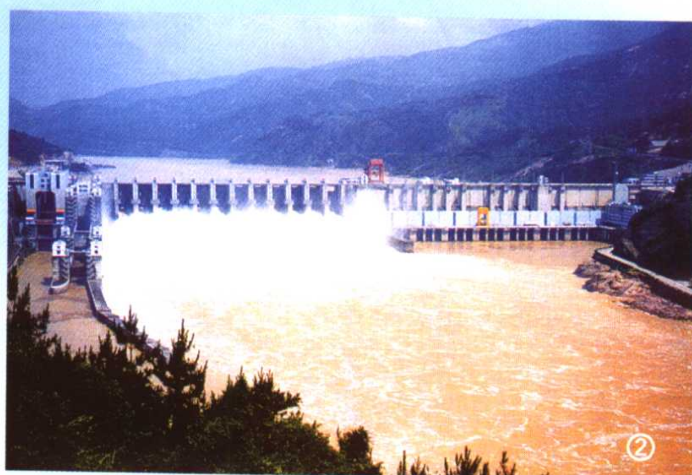
水口枢纽工程
