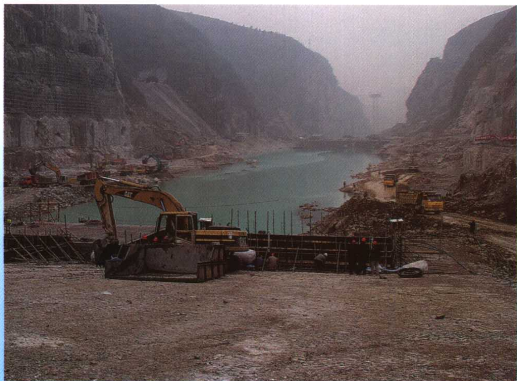
思林水电站大坝基坑
