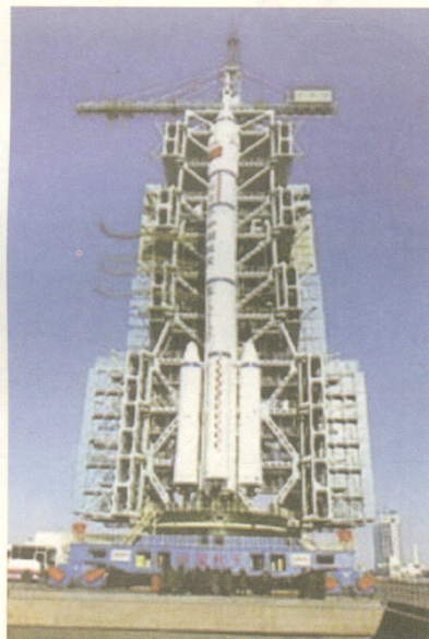
图1.6 飞船发射塔的桁架结构
