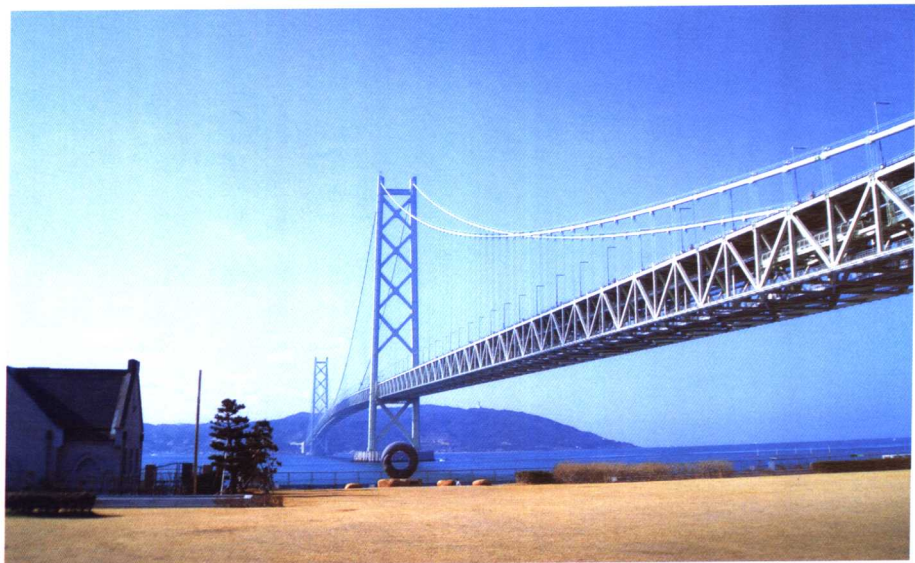
明石海峡大桥
