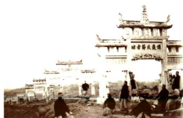
油榨街老牌坊（民国）
