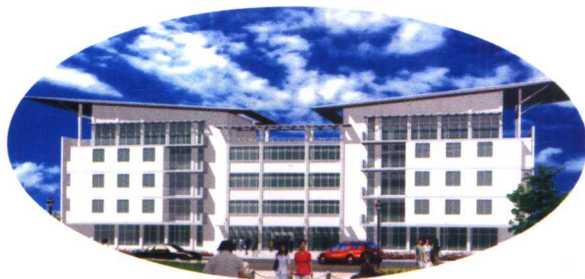
国家高技术产业化示范工程——八峰药化 药用L型氨基酸系列产品工业园生产调度中心
