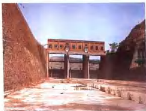
主溢洪道进口
