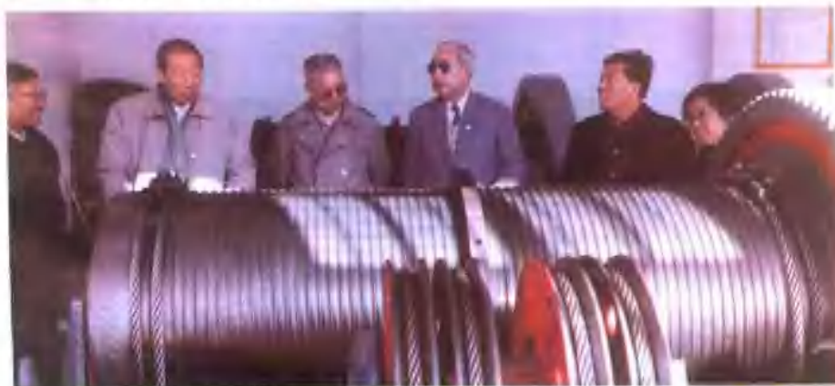
窄口水库大坝安全论证组成员检查泄洪洞闸门启闭机
