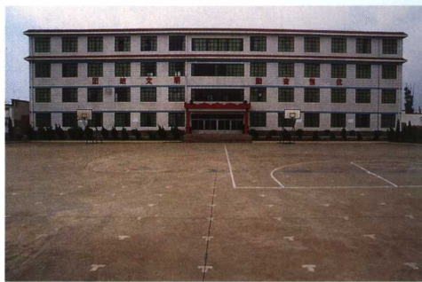
镇属中心学校教学楼
