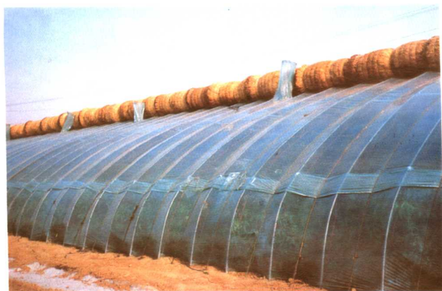
无柱日光温室冬 季生产风筒通风
